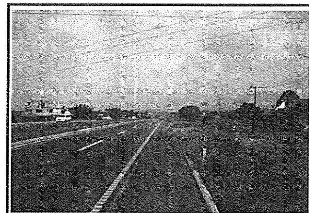
SE OBSERVA EL DEECHO DE VÍA CUERPO "B", GURNICÓN EN AMBOS LADOS, INDICADORES DE ALINEAMIENTO CON REFLEJANTE BLANCO EN AMBOS LADOS EN EL KM 30+500
