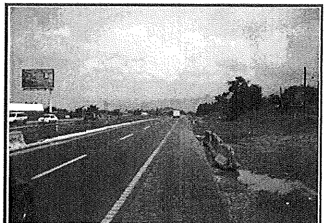
SE OBSERVA EL DEECHO DE VÍA CUERPO "B", GUARNICION EN CEMELLÓN CENTRAL Y BARRERAS DE CIERRE DE SALIDA DE CAMINO EN EL KM 29+500
