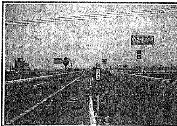
SE OBSERVA EL DEECHO DE VÍA CUERPO "B", GUARNICIÓN AMBOS LADOS, INDICADORES DE ALINEAMIENTO CON REFLEJANTE BLANCO Y SEÑALES INFORMATIVAS DE IDENTIFICACIÓN EN EL KM 32+000
