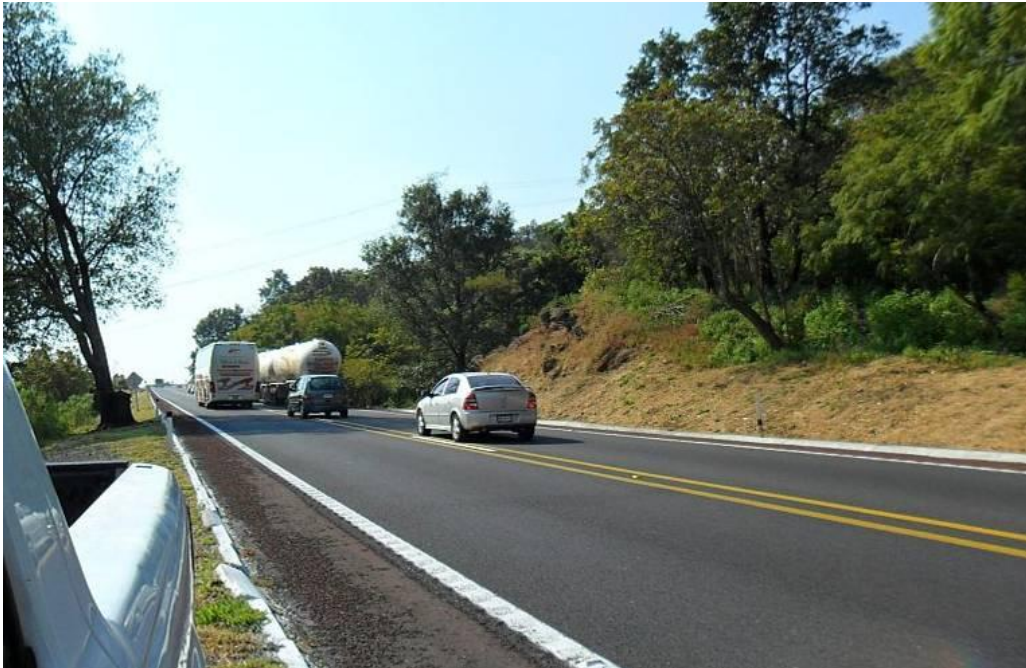
Fotografía 4. Rebase de vehículos en zona de ascenso, a pesar de señalamiento horizontal y vertical de no rebasar. Se nota pendiente fuerte y sostenida, vista hacia La Pera.
