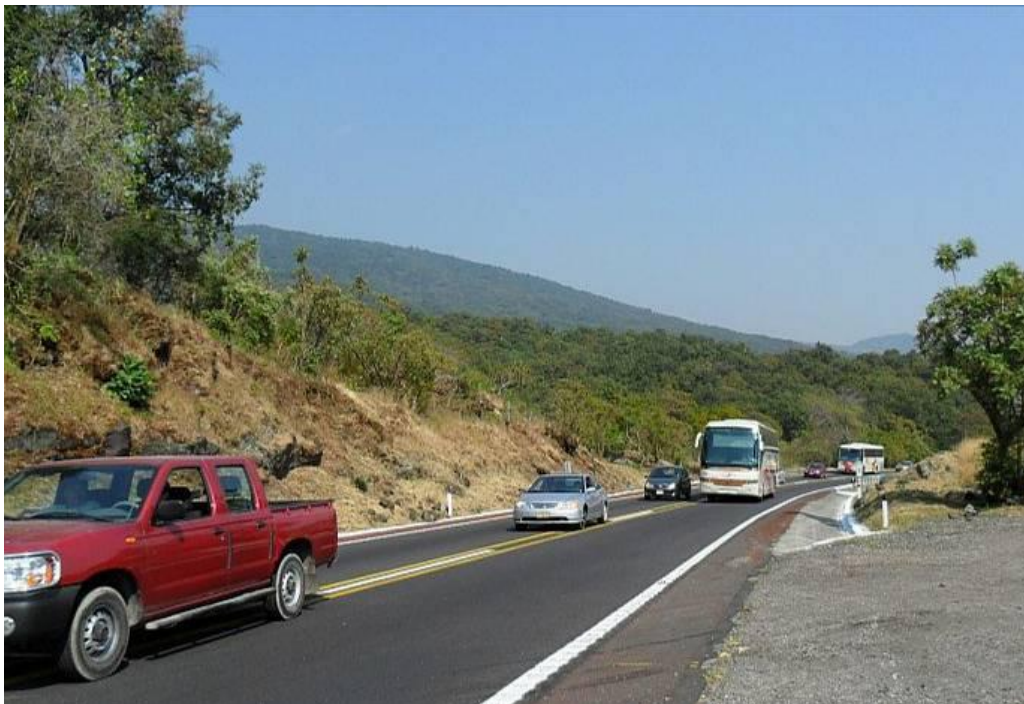
Fotografía 3. Rebase de vehículos en zona de curvas, a pesar de señalamiento horizontal y vertical de no rebasar. Se nota pendiente fuerte y sostenida, vista hacia Cuautla.
